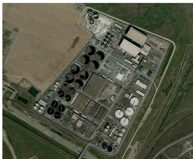
Abb. 1: Kläranlage Bran Sands
