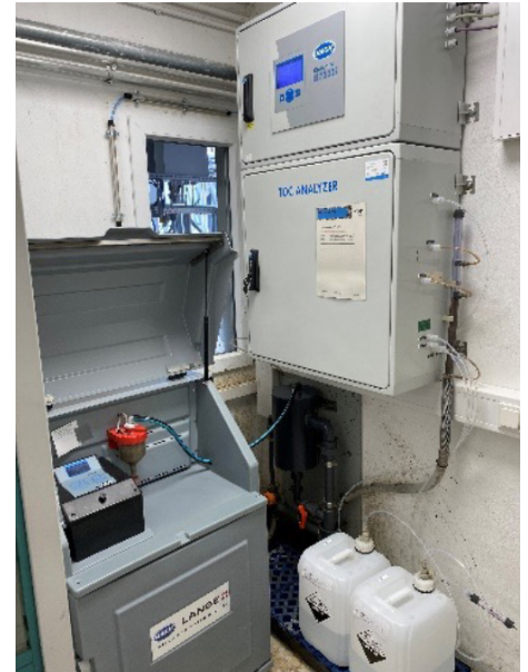
Hach BioTector B7000i und Probennehmer Buhler 3011
