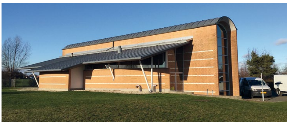
Die wissenschaftliche Arbeit wurde am dänischen Standort Lundeværket, einem Teil von Vandcenter Syd durchgeführt. Es handelt sich um ein für Dänemark typisches Wasserwerk.
