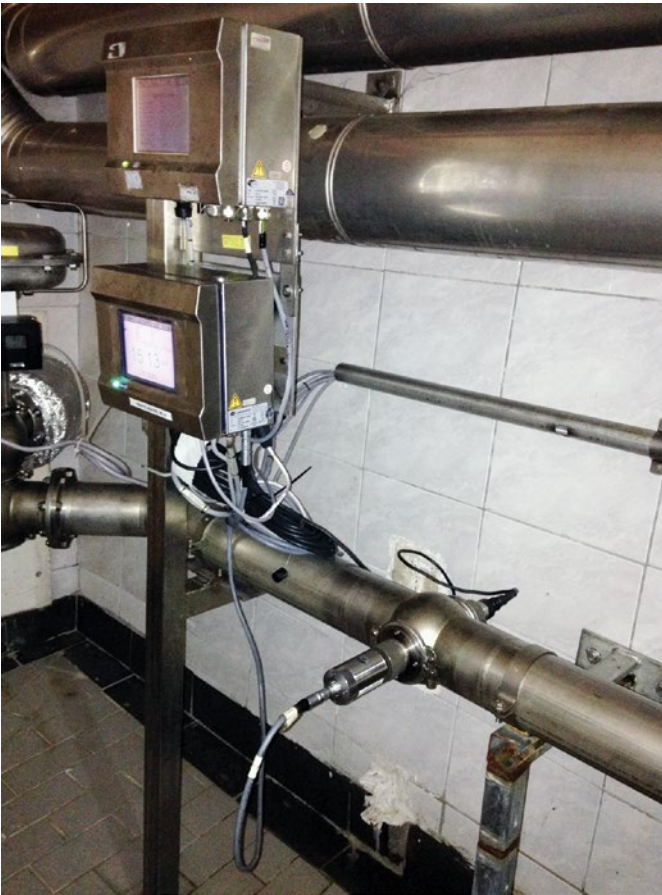
Abb. 2. Hach 410 Controller – typische Installation
